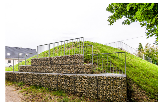
Außenansicht nach Fertigstellung
