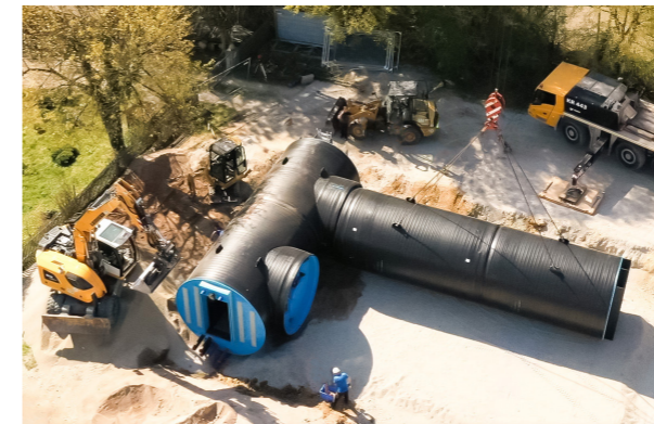
Versetzen des PE-Behälters auf der Baustelle
