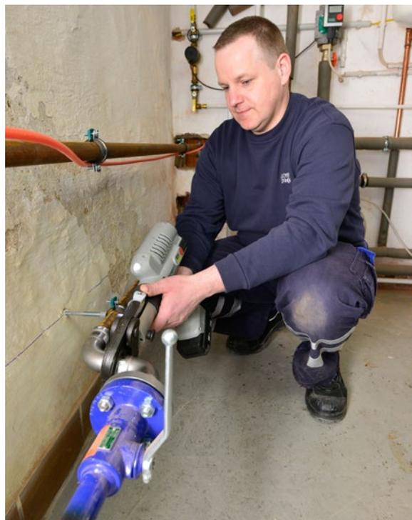
*Ab Hauseinführung und Absperrventil geht es zügig: Rohrnetzmonteur Carsten Doege bei der Verpressung der Rücklaufleitung von der Wärmeübergabestation.*
