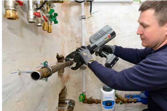
*Bei der Anbindung der Übergabestation spielte die Pressverbindungstechnik alle Systemvorteile aus: Dank des kompakten Presswerkzeugs konnte Rohrnetzmonteur Tobias Hölscher die Verpressungen selbst unter beengten Platzverhältnissen vornehmen und die direkt daneben verlaufende Kunststoffleitung musste im Gegensatz zum Schweißen auch nicht geschützt werden.*
