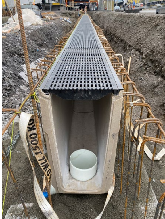
Moderne Rinnensysteme ermöglichen die Ableitung wahlweise seitlich oder nach unten
