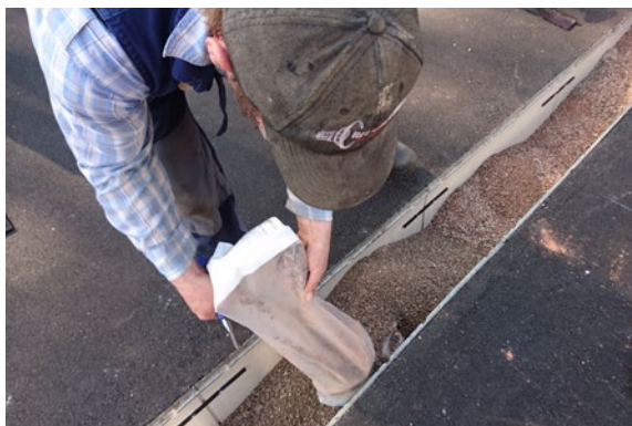
Befüllung der installierten Rinne mit Biocalith® als technischem Filtermaterial
