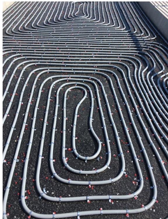
Bild 3: Installierte Heizschleifen auf der Tragschicht der Brücken in Ingolstadt.
