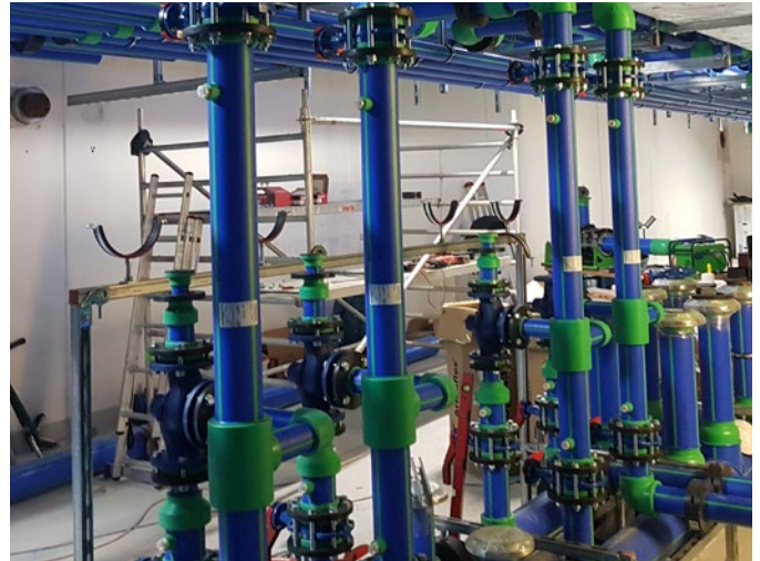
Die Verteiler wurden in der aquatherm Vorfertigung hergestellt und einbaufertig auf die Baustelle geliefert. Foto: aquatherm GmbH
