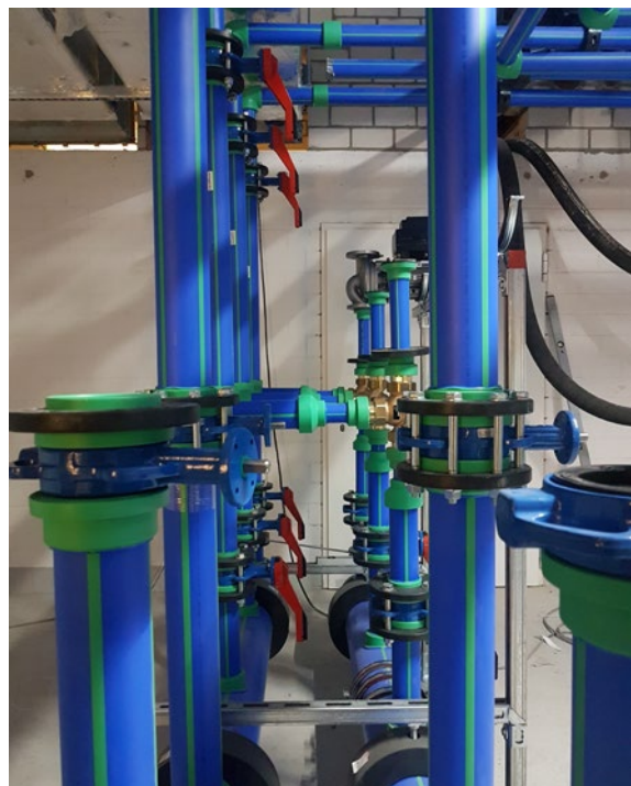
Korrosionsfrei, sicher in der Verbindung, hohe Form- und Druckbeständigkeit sowie geringe Längenausdehnung dank Faserverbundtechnologie. Diese Eigenschaften besitzt aquatherm blue pipe. Foto: aquatherm GmbH
