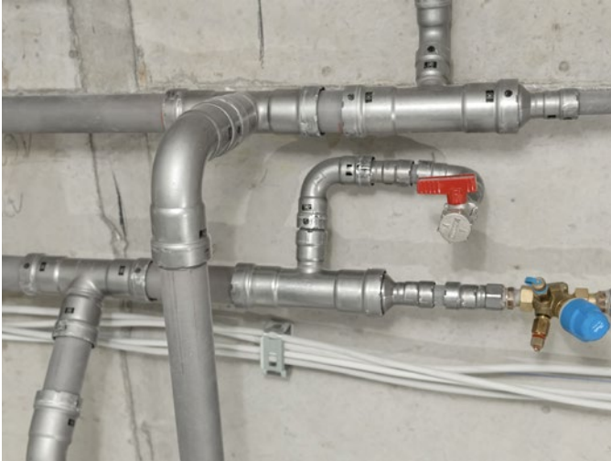
Durch die breite Palette an Formteilen erwies sich das „Megapress“-System als echter Problemlöser für die unterschiedlichsten Installationsaufgaben.
