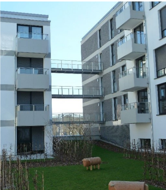
Baufortschritt, © RVI GmbH, Saarbrücken
