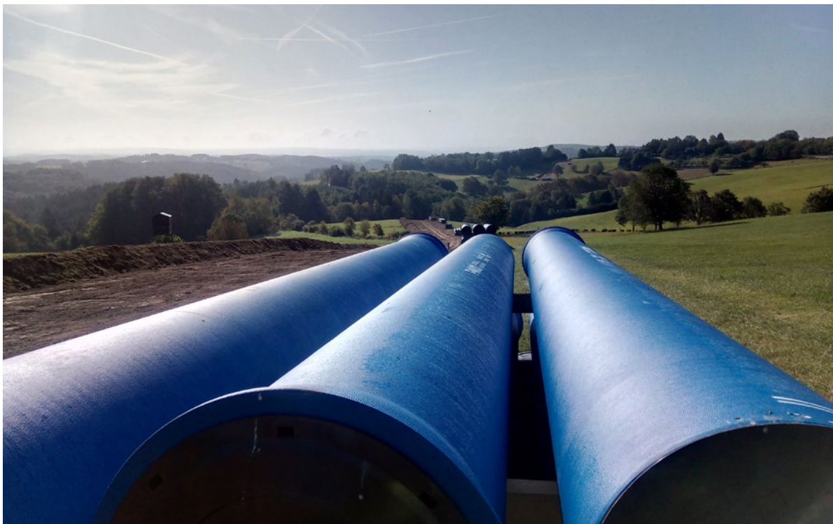
Bild 2: Foto von B. Schade, Gebr. Becher Rohrleitungsbau GmbH
