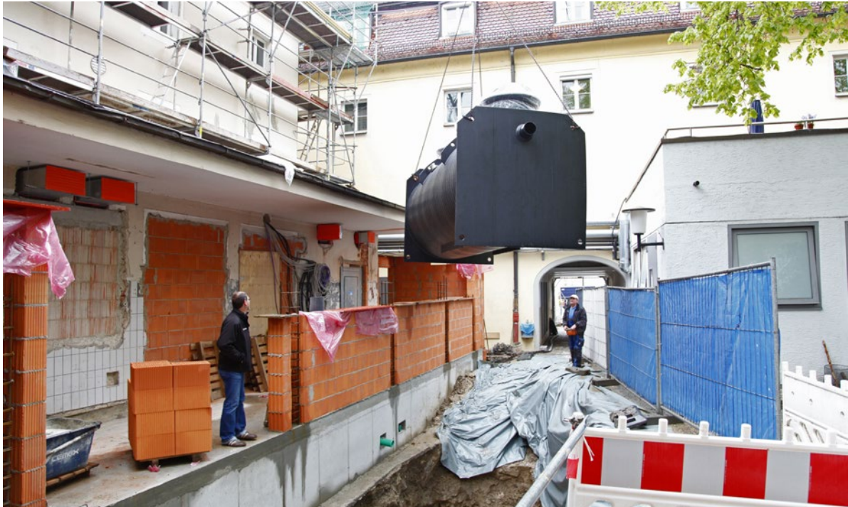
Bild 5: Die angelieferten Einzelteile gelangten per Kran in die offene Baugrube. Anschließend installierten die Monteure Abscheider und Hybrid-Hebeanlage. (Bild: KESSEL AG)
