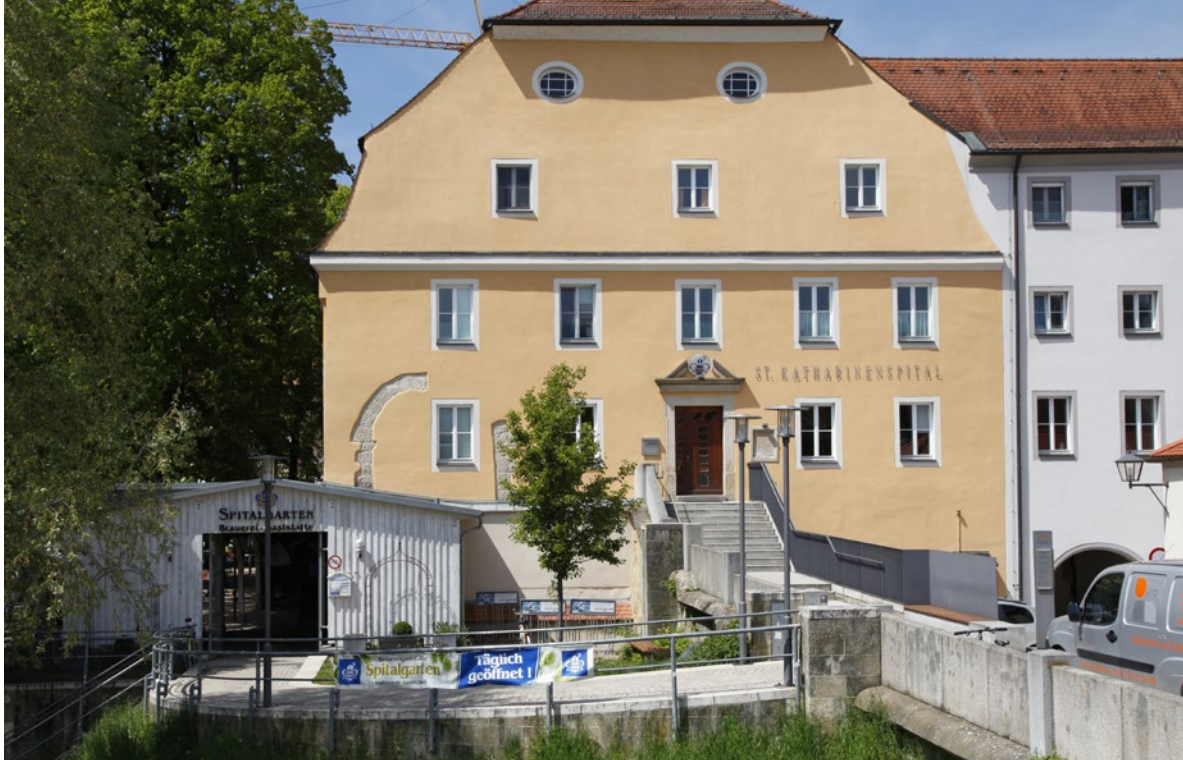
Bild 1: Der Spitalgarten ist eine Regensburger Traditionsgaststätte. 2017 entschied sich der zuständige Regensburger Spitalrat für eine umfassende Sanierung des Gebäudes und der Ausstattung. (Bild: KESSEL AG)
