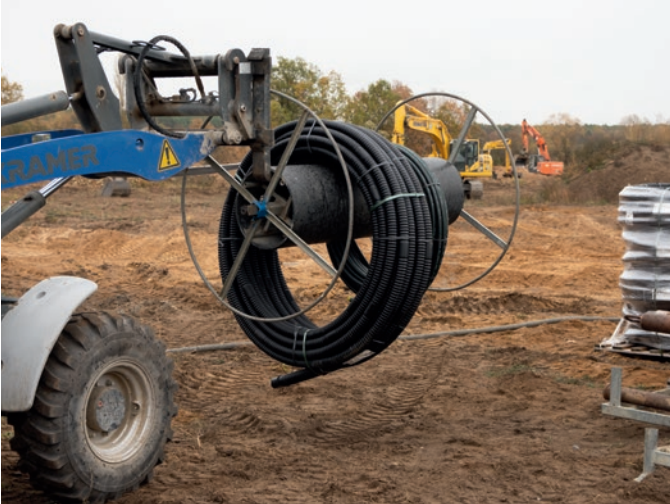
Werksgeschweißte Hochleistungs-Erdwärmesonde in Rollen
