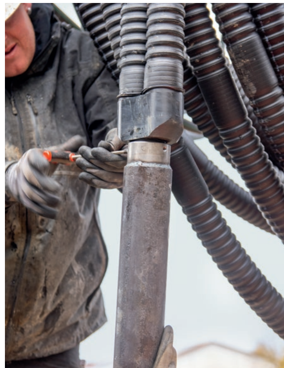
Schnell montierbare und gut gesicherte Sonden-gewichte
