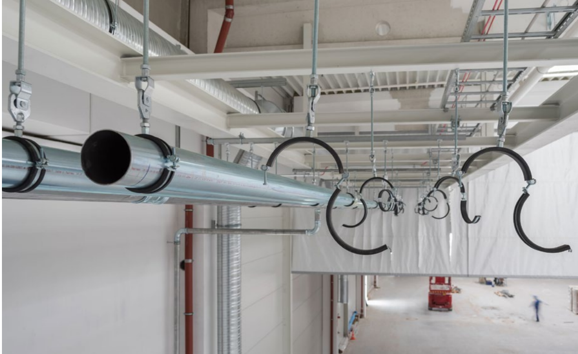
In der Volkswagen Produktionshalle in Braunschweig wurden insgesamt rund 1.200 Meter Rohrleitungen verlegt – viele davon direkt unter der Hallendecke. (Foto: Sándor Kotyrba)
