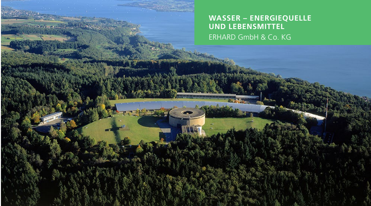
Wasserwerk Sipplinger-Berg, Zweckverband Bodensee-Wasserversorgung
