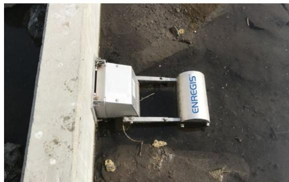
*Das Schwimmersystem „ENREGIS/Limit Control Slide“ verschließt den Zulauf bei Regen, sodass der Niederschlag in die Absetz- und Filterweiche umgeleitet wird.*
