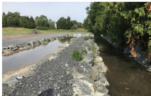
*Rechts der Pulverriedgraben; links der Absetz-/Filterbereich mit ENREGIS/Vivo® TRP am Auslauf.*
