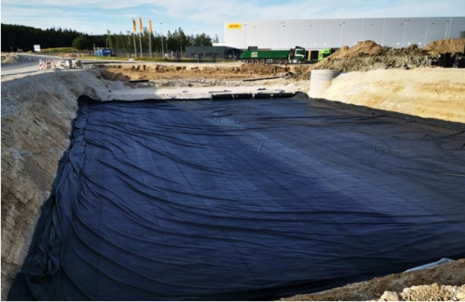
Bild 2: Baugrube im ersten Schritt mit wasserundurchlässigem Material ausgelegt
