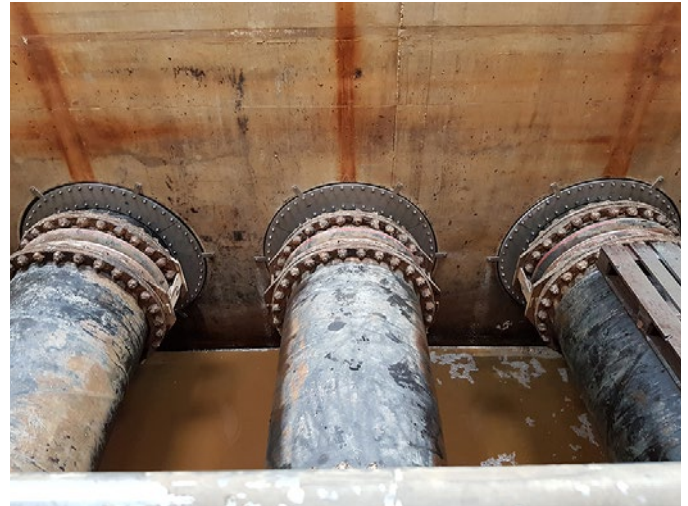
DOYMA lieferte für das Schweiburger Siel geteilte, nicht-zentrische Dichtungseinsätze, die meerwasserbeständig sind und über die bekannten 25 Jahre Garantie verfügen
