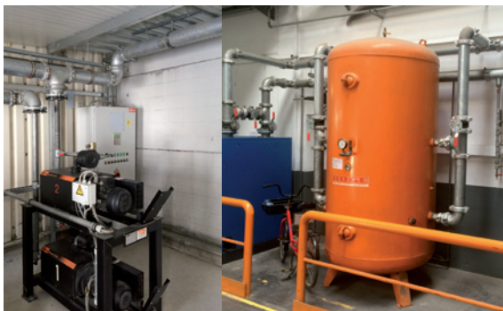
Bild links: Vakuumerzeugung – durch das spezielle Design der Dichtung ist ein Einsatz im Vakuumbereich ohne Weiteres möglich.
