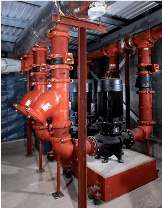
Möglicher Pumpenaufbau im Heizungsbereich
