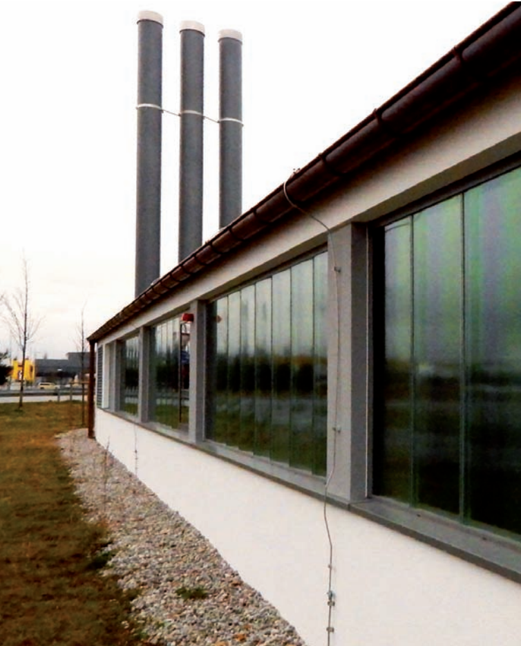
Neubau der Energiezentrale in Germering, Ansicht Süd (Foto: Team für Technik GmbH)
