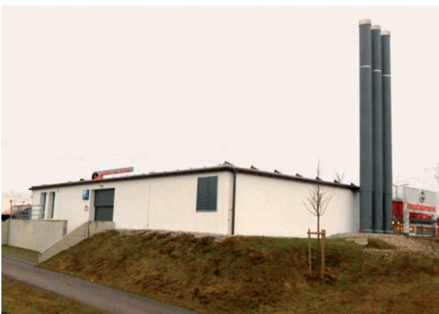
Neubau der Energiezentrale in Germering, Ansicht Nord (Foto: Team für Technik GmbH)
