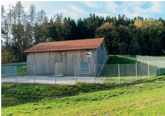
Maschinenhaus Grundwasserpumpwerk Daibersdorf
