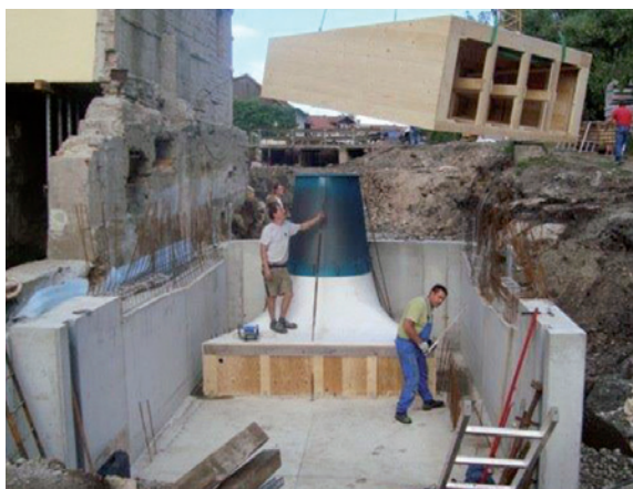
Vom Einbau der Saugrohrschalung ... bis zum fertig installierten Maschinensatz.
