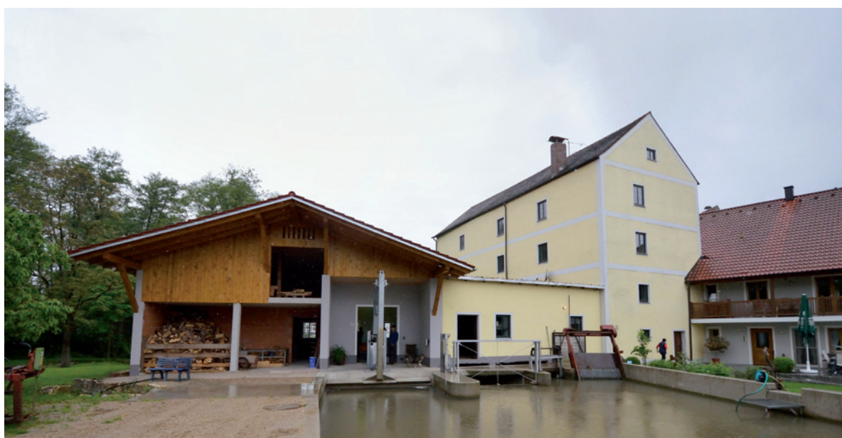
Direkt neben der alten Wasserkraftanlage aus dem Jahr 1927 wurde das neue Kraftwerk errichtet. Dafür hielt sich der bauliche Aufwand in Grenzen – und die Altmaschine konnte erhalten bleiben.
