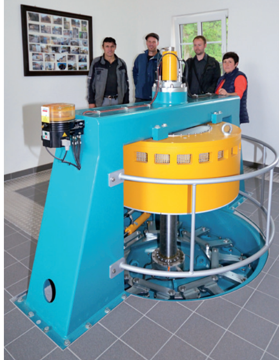
Betreiber Robert Necker, Dipl.-Ing. Christoph Pfeffer, Stefan Heindl und Frau Christine Necker hinter der flüsterleisen Maschineneinheit, einem PMG, der von einer WATEC Kaplanmaschine angetrieben wird.
