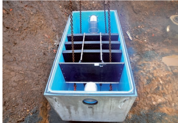
Der ACO Leichtflüssigkeitsabscheider vom Typ Oleo- smart-C NS 90 besticht durch seine filterlose Mehr- kanaltechnologie.
