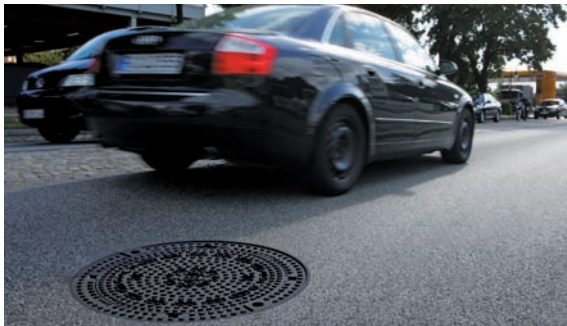
Der oberflächenbündige Einbau der neuen ACO Multitop Plus-Schachtabdeckung sorgt für eine stets ruhige Lage des Deckels beim Überfahren.
