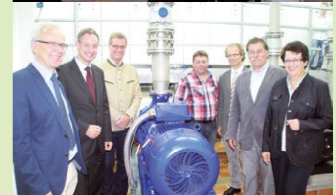
Bild 3 oben: Neues Hauptpumpwerk Straubing Bild 4 unten: Freuen sich über das erneuerte Hauptpumpwerk des Wasserwerks (v.l.): Stadtwerke-Geschäftsführer Helmut Kruczek, OB Markus Pannermayr, Dipl.-Ing. Michael Reißnecker, Wassermeister Josef Ruhland, Bereichsleiter Clemens von Ruedorffer, Bürgermeister Hans Lohmeier, Bürgermeisterin Maria Stenzl.
