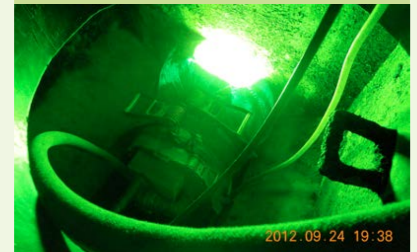
Abbildung 2 (oben): Projektgebiet Abbildung 3 (Mitte): Schadensbild - eindringende Wurzeln (Abflusshindernis) Abbildung 4 (unten): GFK-Liner beim Aushärten mit UV-Licht
