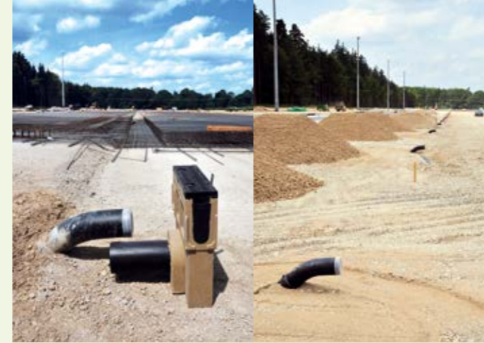
Bild 6 (oben links): Die Anschlussleitungen für die Einlaufkästen sind bereits auf der Gesamtlänge der LAU-Anlage (rd. 650 m) verlegt.
