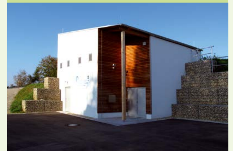
Abbildung 2: Hochbehälter Weiberrast: Schieberkammer und Außenansicht
