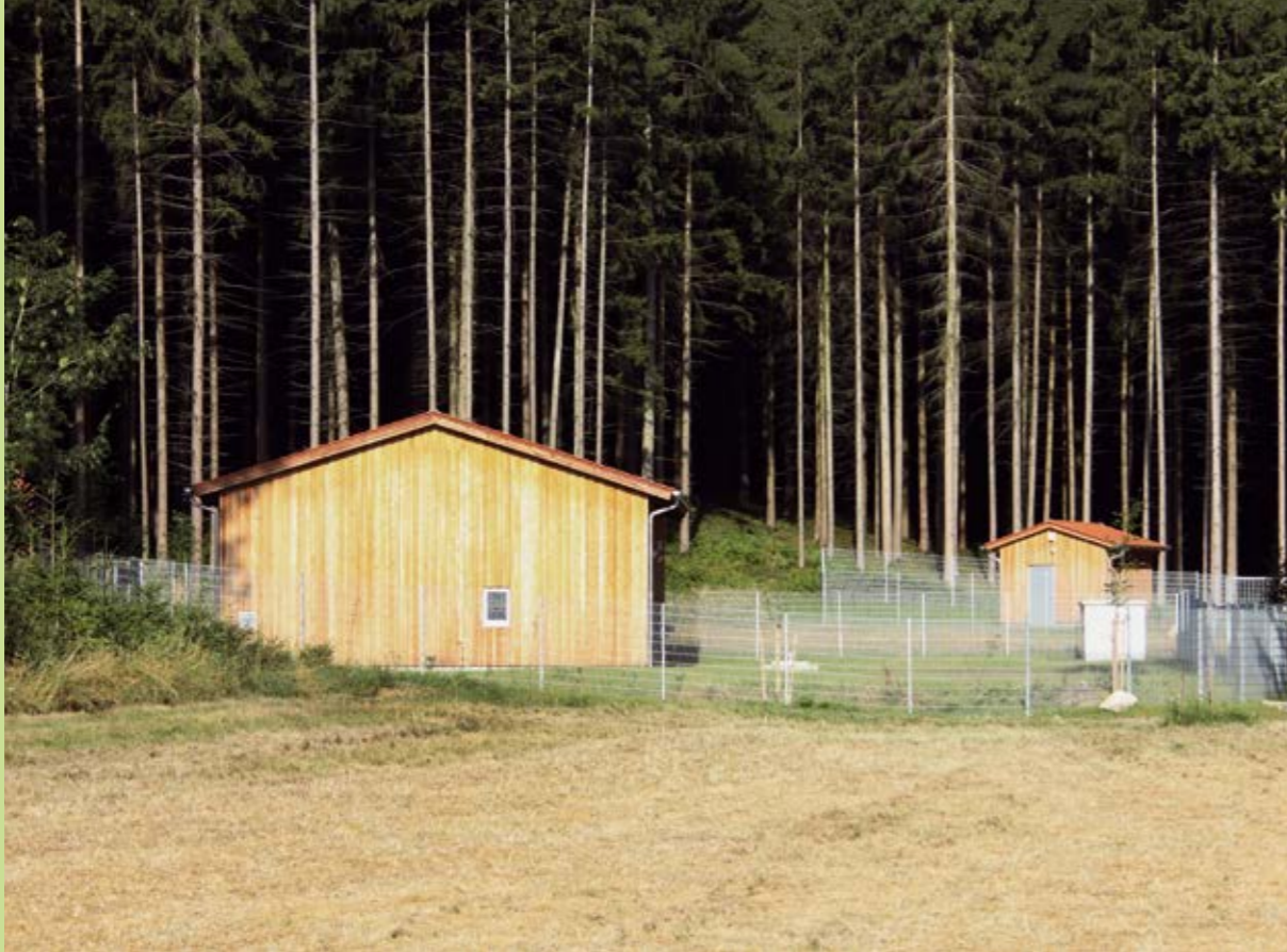
Abbildung 1: Gebäude für Brunnenvorschacht (hinten) und für die Aufbereitungsanlage
