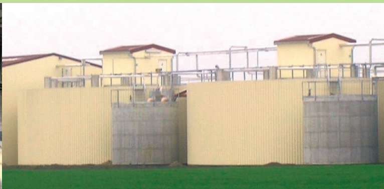
Abbildung 3: Das schlussendlich in den Fermentern entstehende Biogas wird entschwefelt, auskondensiert und in Folienspeichern zwischengelagert (Abbildung 4).
