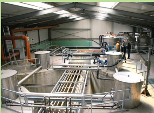
Abbildung 2: In den Hydrolysetanks finden die ersten mikrobiellen Prozesse der Biogasgewinnung statt.
