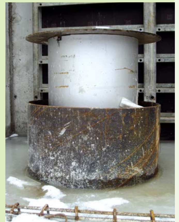
Abbildung 3: Entnahmebrunnen mit Sperrrohr
