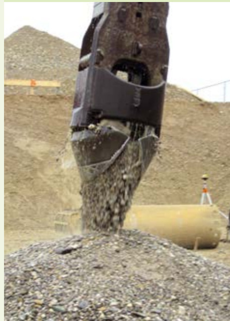
Abbildung 1: Abteufen im Greifbohrverfahren
