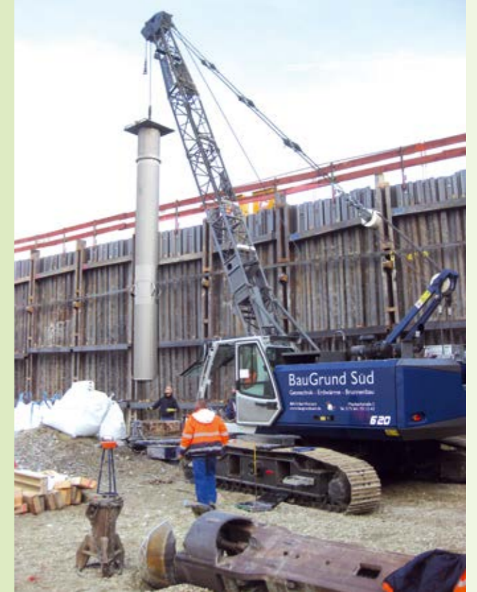
Abbildung 2: Einbringen der Verrohrung
