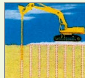
Ziehen des Stahlrohres
