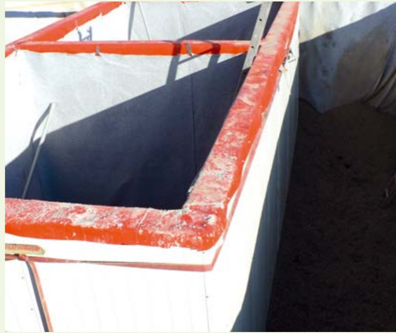
Grafik 4: Sandwichhülle mit Vlies-Speicherdichtung
