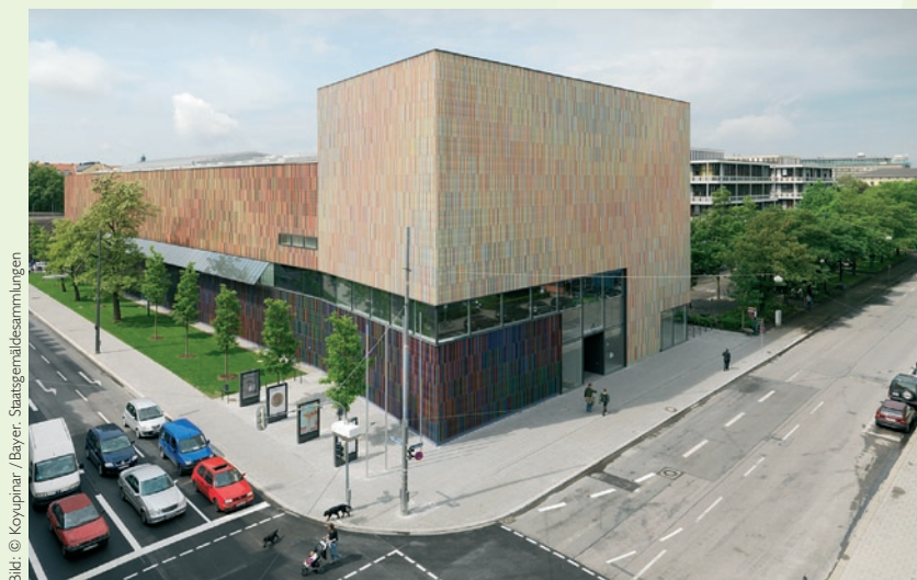
Bild 1: Das Brandhorst Museum in München wird über drei Kältemaschinen/Wärmepumpen monovalent mit Wärme und Kälte versorgt.
