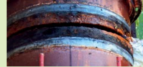
Die alten Kupplungen wurden auf den Seiten in Längsrichtung aufgeschnitten und die so entstandenen Halbschalen entfernt.
