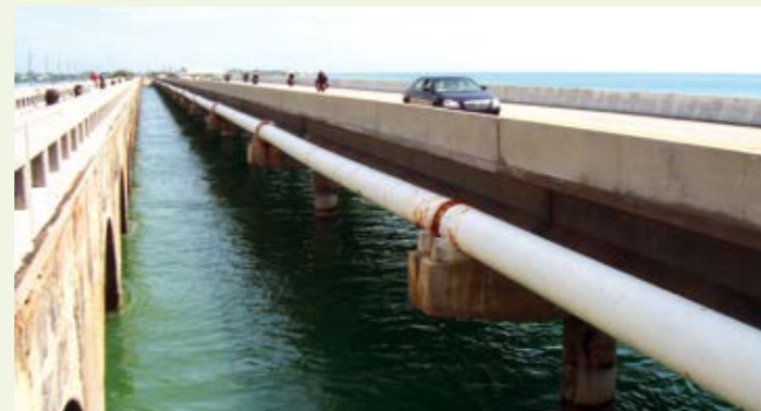
Die Trinkwasserleitung nach Key West ist seitlich der Brücken auf Konsolen montiert.
