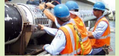
Die neuen Gehäuse-Halbschalen wurden um das Rohr gelegt und mit Verschlusschrauben in tangentialer Richtung angezogen.
