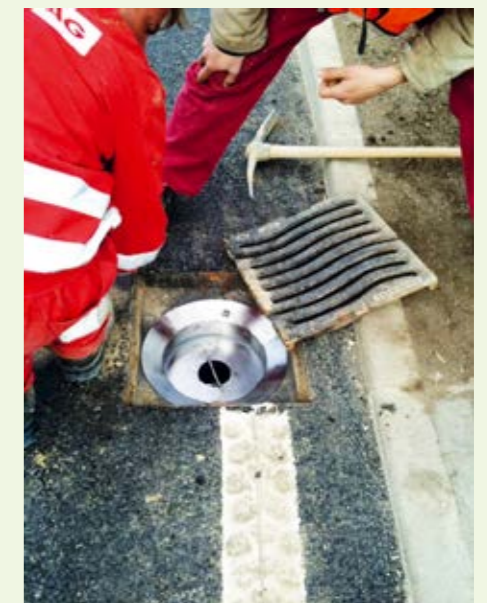
Abbildung 4b: Einbau des Envia-Straßeneinlaufsystems CRC
